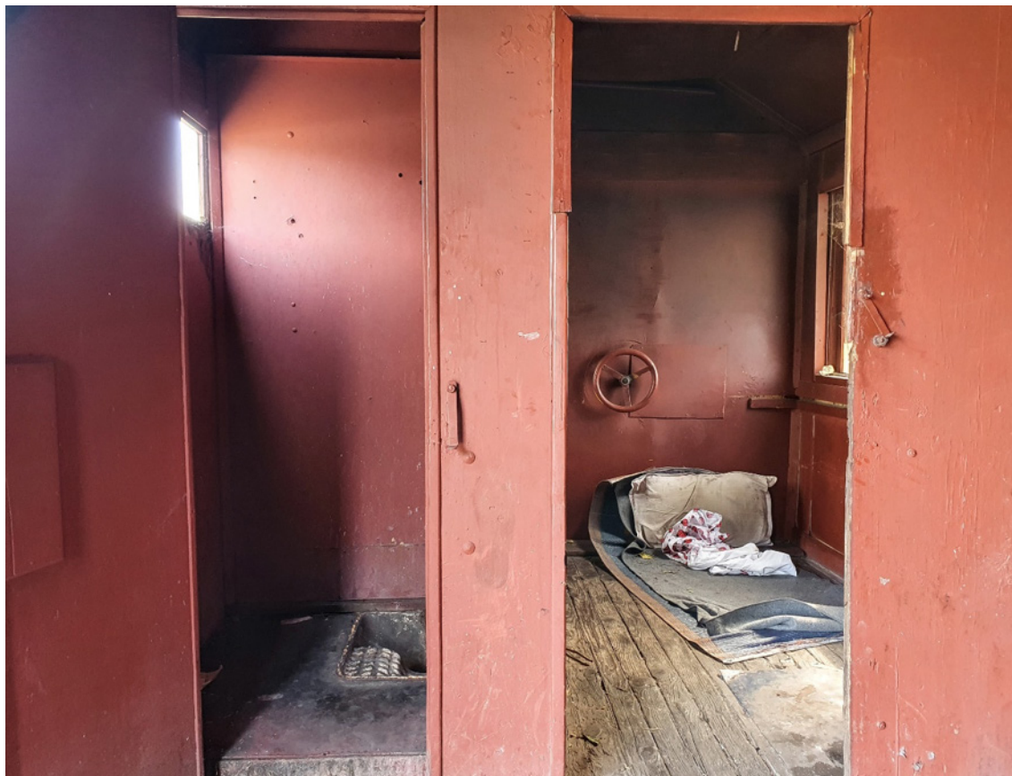
Estació abandonada als afores de Subotica, a pocs kilòmetres de la frontera amb Hongria i campament informal i de pas de persones refugiades. Font: CCAR
